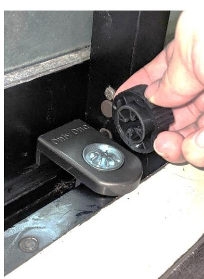
黒い鍵部分を半時計回りに回転させ、本体裏の金具の幅をレールの幅より狭くします。
