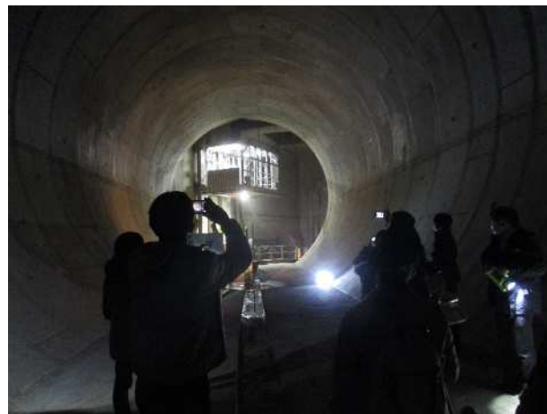
白子川地下調節池
