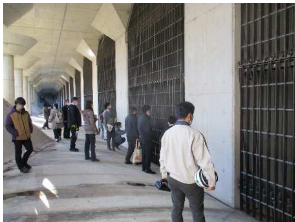
比丘尼橋下流調節池
