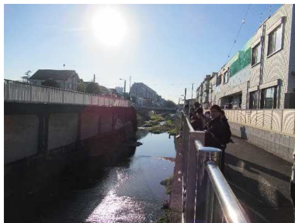
比丘尼橋上流調節池
