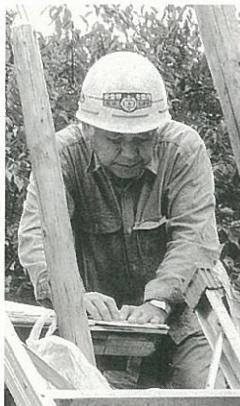
（内容）檜皮葺は、檜の立木の表皮を加工したものであり、柿葺は柿などの材料で薄板を作り、いずれも竹釘をもつて野地面に打ち付ける。保持者はこれらの技術と、銅板を屋根の形に合わせて加工して葺きあげる銅葺の技術を持つ。
