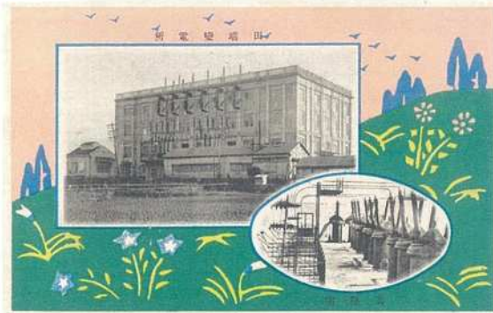
写真2 絵葉書「田端変電所 高圧室」
