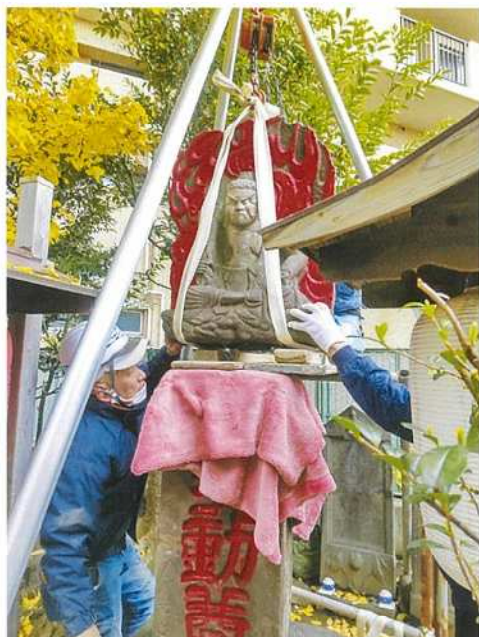
袈裟塚耳無不動の修理作業
