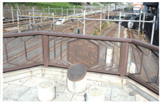
課題写真③ 下御隠殿橋(トレインミュージアム)
