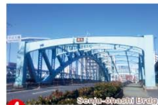
④ 千住大橋 【南千住6-71 付近】
