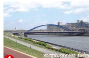
④ 水神大橋
