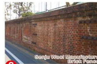
⑥ 旧千住製絨所煉瓦塀 【南千住6-43 付近】
