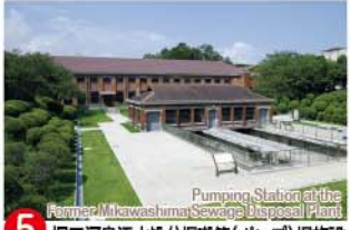
⑤ 旧三河島汚水処分場唧筒(ポンプ)場施設 【荒川8-25-1】
