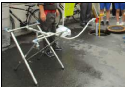
[指定消火栓からの給水風景]
