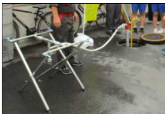
[指定消火栓からの給水風景]
