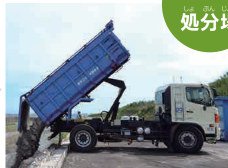
現在の埋立処分場 (平成30年)
