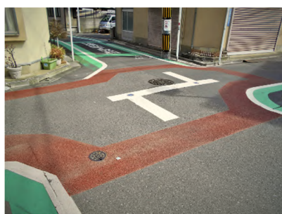
（カラー舗装、すべり止め舗装 交差点標示、道路鋳）
