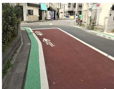
（カラー舗装、すべり止め舗装 自転車ナビマーク）
