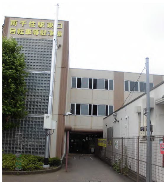
南千住駅東口自転車等駐車場
