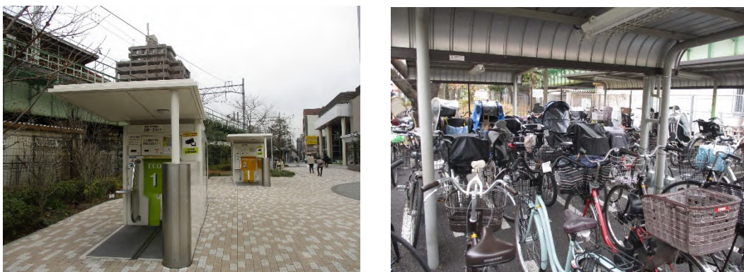
図 5-15 三河島駅前自転車駐車場の地下機械式駐輪場及び平置場の様子
