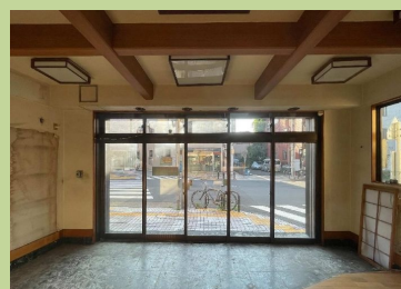
改修前の空き家
