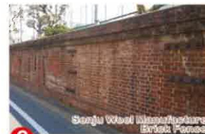
⑥ 旧千住製絨所煉瓦塀 【南千住6-43 付近】
