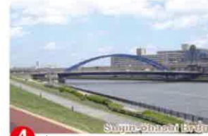
④ 水神大橋
