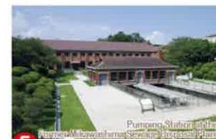
5 旧三河島污水処分場唧筒(ポンプ)場施設 【荒川18-25-1】
