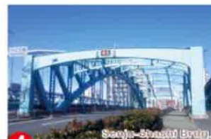
④ 千住大橋 【南千住6-71 付近】
