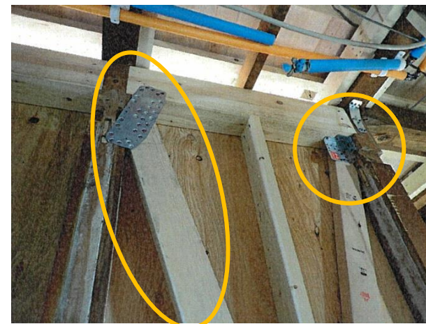
▲耐震補強工事施工の様子 (筋交い、金物等による補強)
