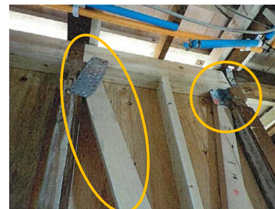
▲耐震補強工事施工の様子 (筋交い、金物等による補強)
