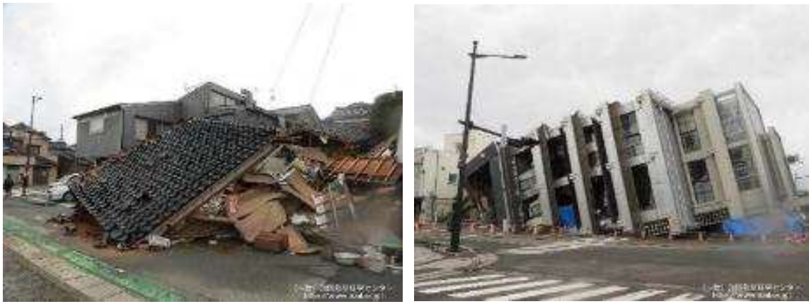
図 1-9 能登半島地震における建物被害状況
