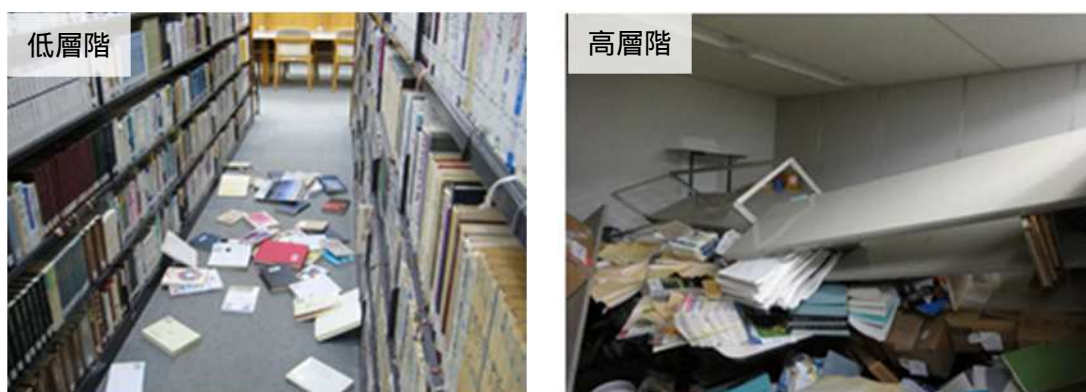
図 1-5 東京都内の同一ビルにおける低層階と高層階の被害状況 出典：「気象庁ホームページ」
