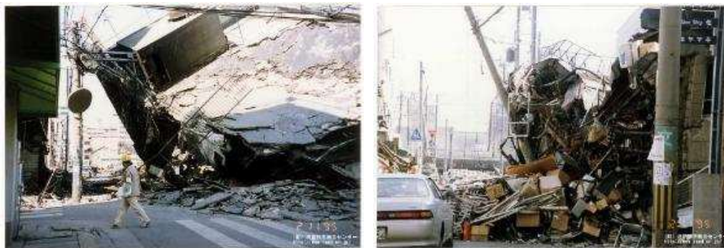
図 1-4 建物倒壊による道路閉塞
