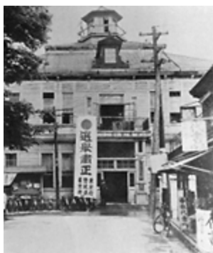
昭和7(1932)年 荒川区発足当初の庁舎
