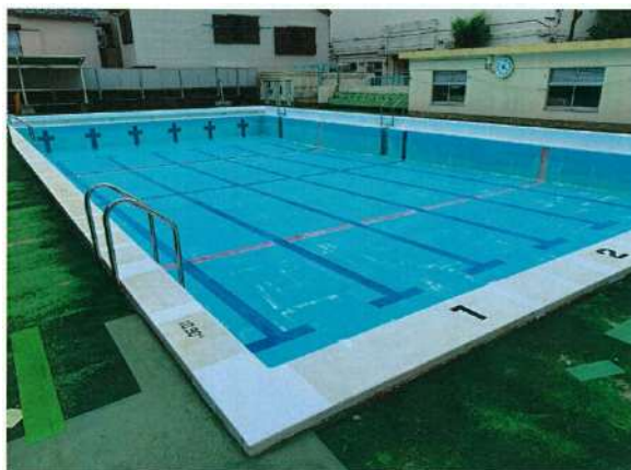
【塗装工事实施後の学校プール】
