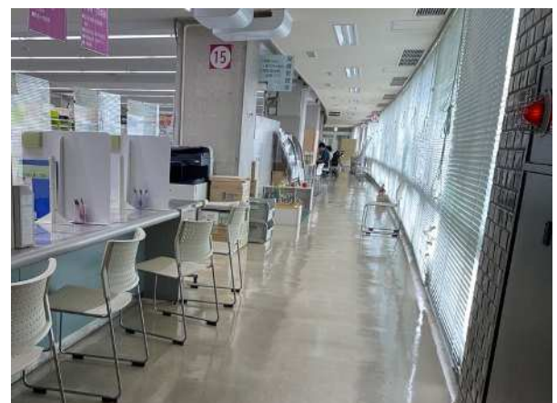
断熱性能の低いガラス窓
